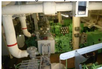
Overzicht deel van machinekamer
