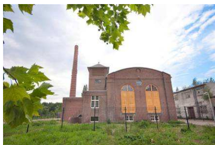
Vooraanzicht van ketelhuis, met op de voorgrond de machinekamer
