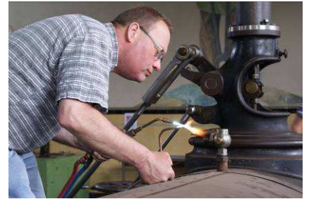
Uiterst geconcentreerd soldeert Arno een deel van de koppeling aan de smeerleiding
